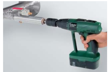
Anbohren unter Druck
