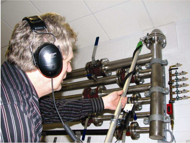
Bild 10 Leckagensuche an undichten Flanschen
