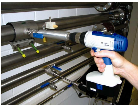
Bild 6 Anbohren unter Druck
